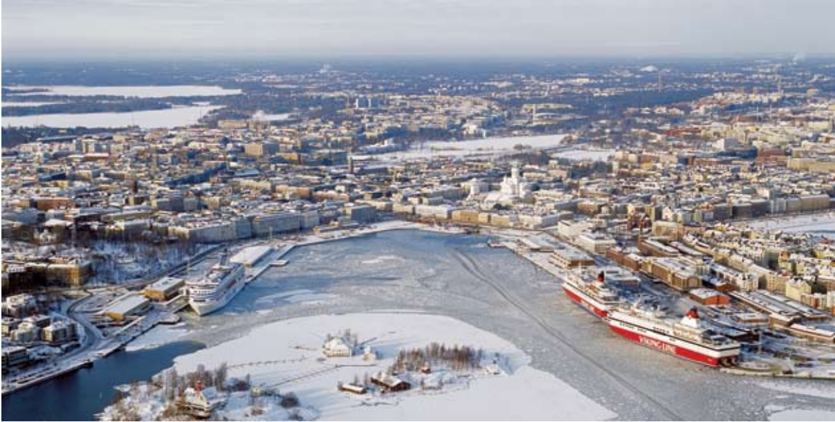
Helsingin satamien kautta kulkee yli puolet koko maan matkustajaliikenteestä. Laivaliikenteen hiilidioksidipäästöjen vähentämiseen liittyvä keskustelu on vasta käynnistymässä. Kuva: Hannu Vallas / Lentokuva Vallas Oy
