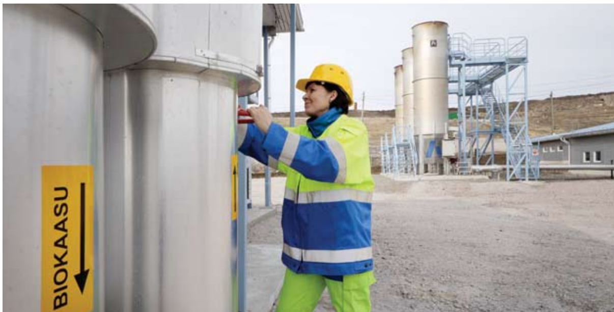
Biokaasun talteenottoa Ämmäsuon kaatopaikalla. Kaasua käytetään Kivenlahden lämpökeskuksessa kaukolämmön tuotantoon. Kuva: YTV / Hannu Bask
