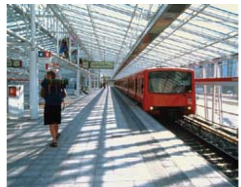
Vuosaaren metroasema. Kuva: HKL
