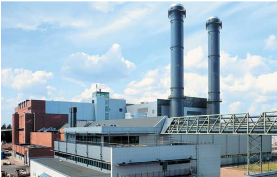
Vuonna 1998 käynnistyi pohjoismaiden suurin maakaasua käyttävä yhteistuotantovoimalaitos Vuosaari B. Kuva: Helsingin Energia
