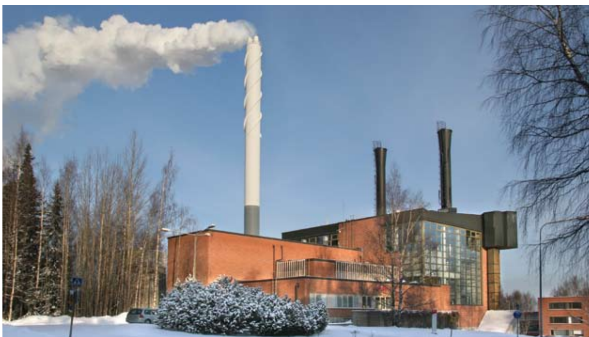
Kaukolämpöverkolle epäedullisia reunaehtoja tulee selvittää ja poistaa kaupunkien ja valtiovallan toimin. Kuva: Pertti Hakari / Diabox
